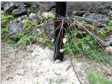
Das Radialnetz der 80-m-Vertikal mit Spule zur besseren statischen Ableitung
